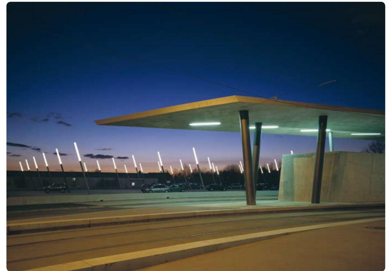
Terminal Nord du Tram à Hoenheim (67) Conception : Zaha HADID
